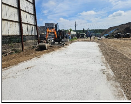
주차장 패드 콘크리트 진출입 경사로 설치
