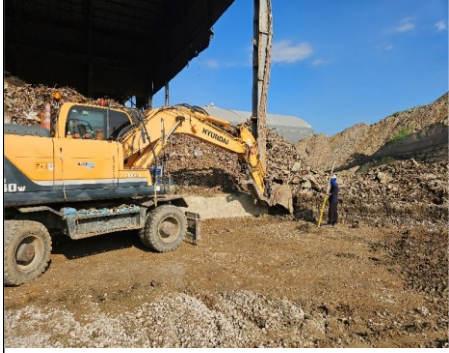
중축 건축물 기초 터파기
