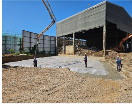
중축 건축물 기초 버림콘크리트 타설
