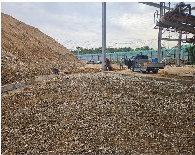
기존동-증축동 진출입로 패드 콘크리트 거푸집 설치
