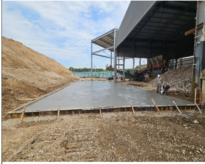
기존동-증축동 진출입로 패드 콘크리트 타설 완료
