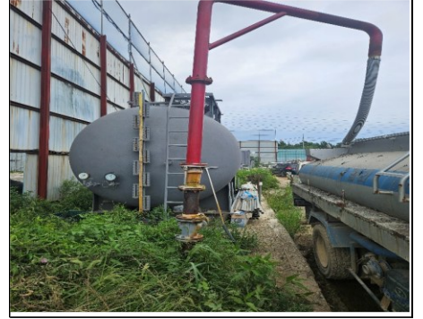
증축 건축물 지상식 소화전 설치
