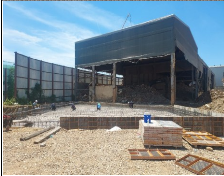
중축 건축물 기초 철근 조립 및 거푸집 설치
