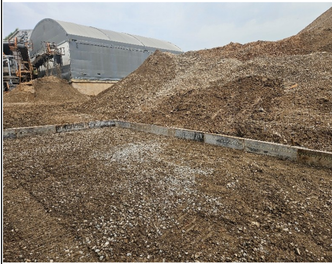
기존동-증축동 진출입로 패드 콘크리트 거푸집 설치
