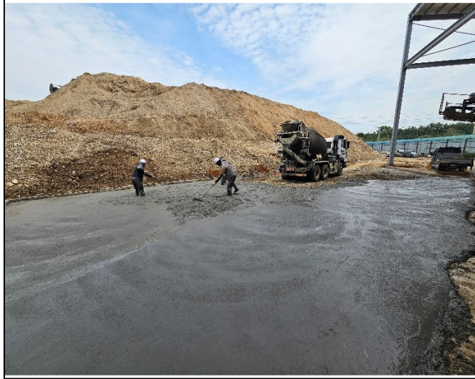
기존동-증축동 진출입로 패드 콘크리트 타설 완료
