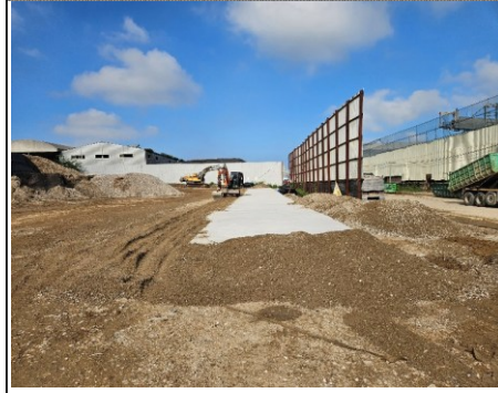
주차장 패드 콘크리트 진출입 경사로 설치
