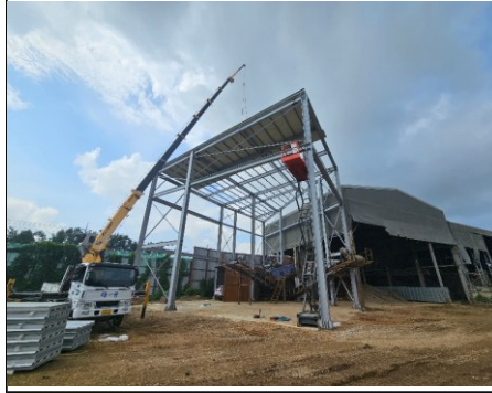
중축 건축물 지붕 판넬 설치
