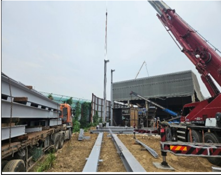
중축 건축물 철골 설치
