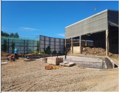
중축 건축물 기초 철근 조립 및 거푸집 설치
