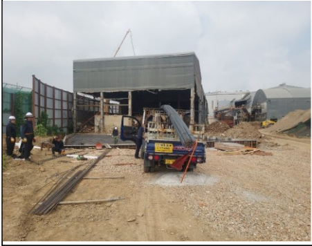
중축 건축물 기초 철근 조립 및 거푸집 설치
