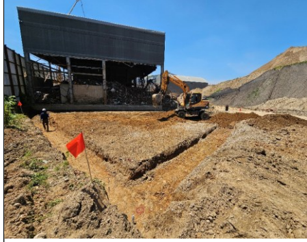
중축 건축물 기초 터파기
