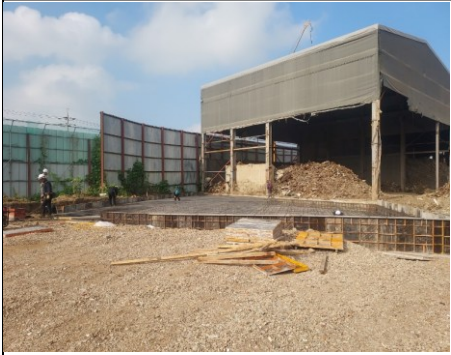
중축 건축물 기초 철근 조립 및 거푸집 설치
