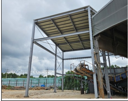
증축동 건축 및 기계 설치 완료
