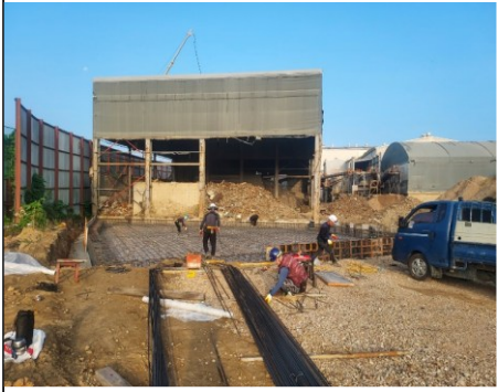
중축 건축물 기초 철근 조립 및 거푸집 설치
