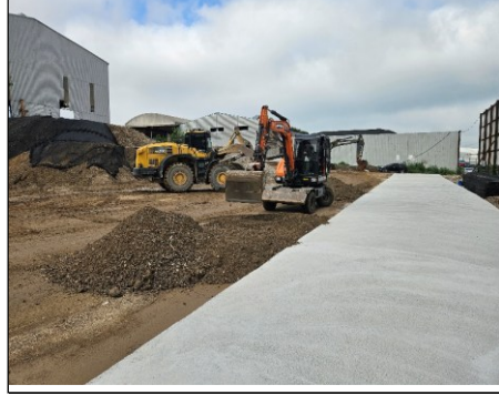
주차장 패드 콘크리트 진출입 경사로 설치
