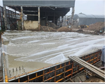
중축 건축물 기초 콘크리트 타설 완료
