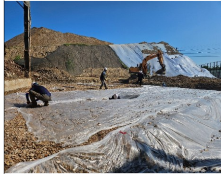
중축 건축물 기초 비닐 깔기
